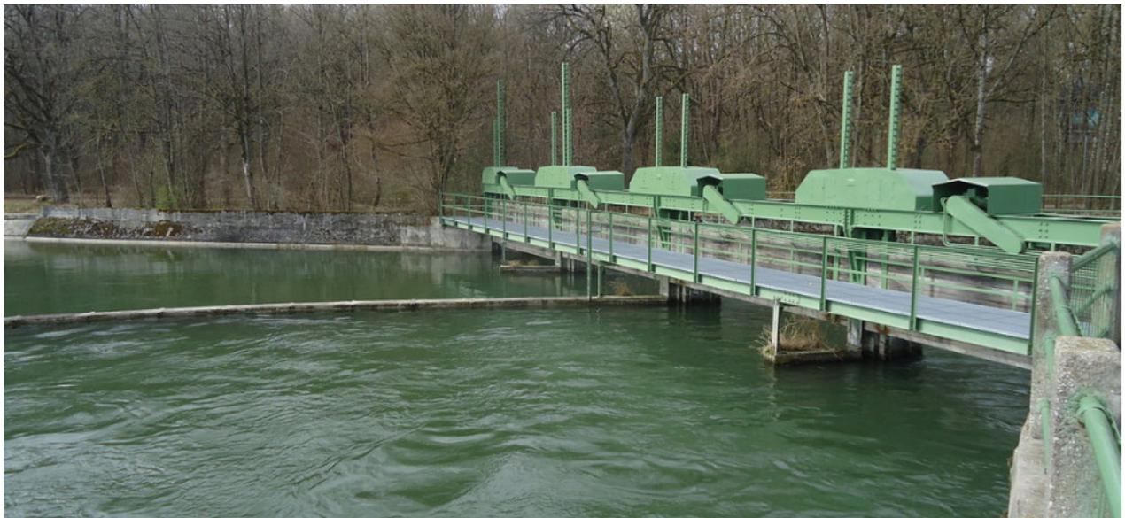
Bei Schließen des Wehrs in den Hauptstadt bach am Hochablass sinkt der Wasserspiegel im Herrenbach auf die unproblematische Restwassermenge innerhalb von ca. 25Minuten. Laut Aussage von Herrn Erben dauerte die Absenkung bei der Katastrophenübung am 19.05.2018 3 Stunden. Diese Zeitdauer löste die sofortige Fällung am 29.05.2018 aus.
